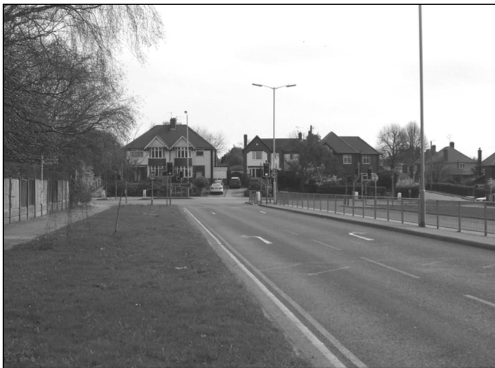
**Рис. 1.5.** Дорожная разметка для поворотов
