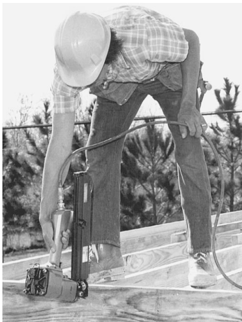
Рис. 1.1. Использование гвоздезабивного пистолета для крепления гвоздями элементов каркасной конструкции (Duo-Fast)
