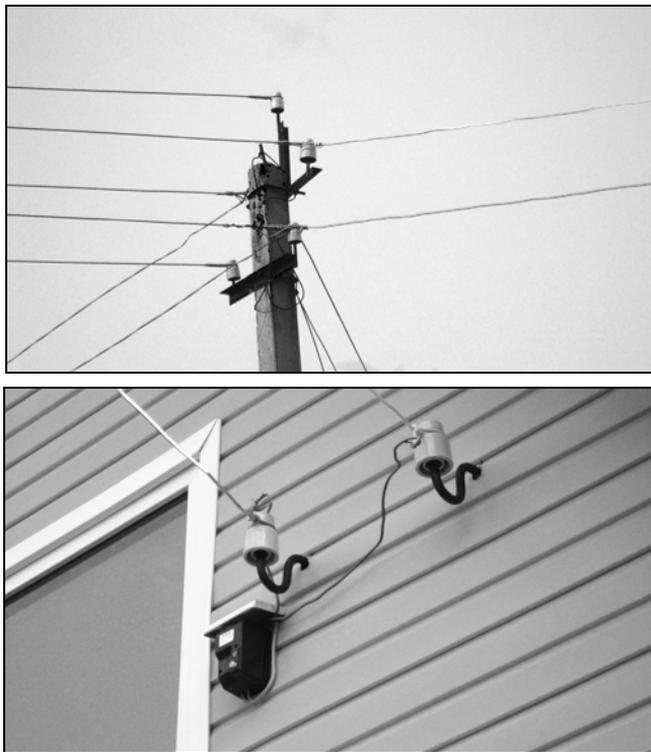
Рис. 1.2. Подвод электричества к загородному дому
