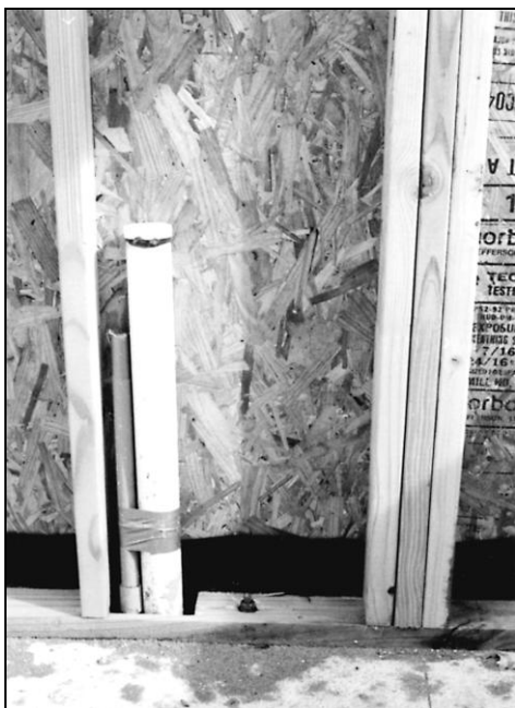
Рис. 1.4. Сантехнические трубы, установленные между внутренней и наружной стенами
