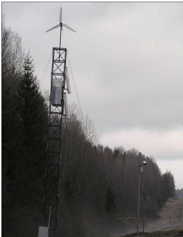
Рис. 1.2. Автономные камеры вдоль дорог. Питание от ветрогенератора
